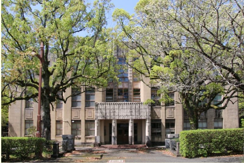
北東側外観。徳山産御影石を混ぜた人造石仕上げのRC造3階建て。県有施設としては初のRC造。2階腰壁に並ぶ矩形の意匠はセセッション。細部意匠は ज्याマン・セセッション。
