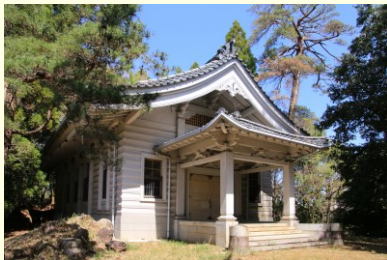
防長先賢堂〔昭和3年〕 昭和3(1928)年建設。RC造平屋建て、瓦葺き、高床式校倉造りの外観。校木、斗拱、臺股、懸魚など伝統的木造の意匠が緻密に表現されている。
