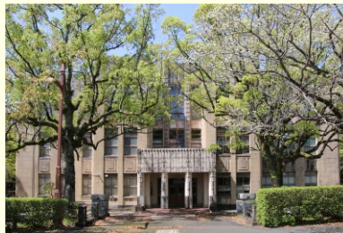
二代目山口県立図書館書庫〔昭和3年〕 徳山産御影石を混ぜた人造石仕上げのRC造3階建て。県有施設としては初のRC造と思われる。2階腰壁に並ぶ矩形の意匠はセセッション
