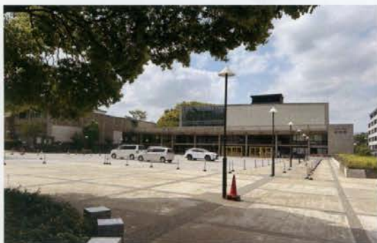
東側の前庭から見る音楽堂(右)と図書館
